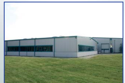
Produktionshalle 4 Production hall 4
