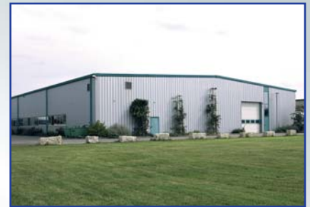
Produktionshalle 3 Production hall 3
